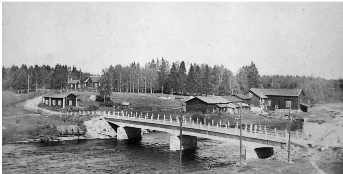
Koitajoen silta Möhkössä ennen sotia. Kuva: Ilomantsin Museosäätiö
